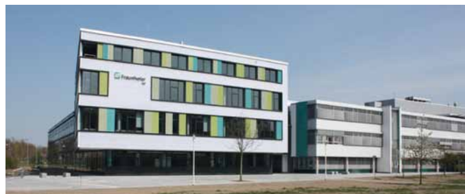
Zweite Ausbaustufe des Fraunhofer IAP, April 2012
