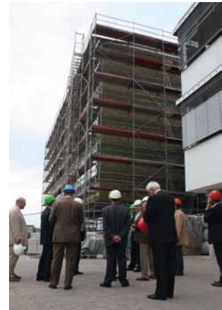
Besichtigung der Bauarbeiten zur zweiten Ausbaustufe des Fraunhofer IAP durch die Mitglieder des Kuratoriums, 8.6.2011.
