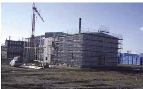
Bild 1: Fraunhofer-Technikas in der Phase der Baurealisierung
